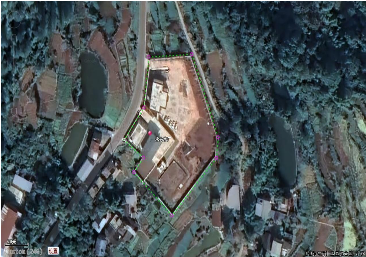
附图 2-1：永兴水厂总平面、风险源分布、应急物资分布、逃生线路图
