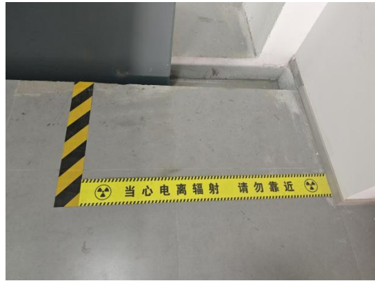
图3-13 工作人员防护门口安全警戒线
