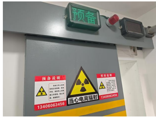
图3-5 “预备”“照射”信号说明及当心电离辐射警告标志
